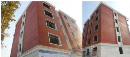
Дом, созданный методом 3D-печати в Китае
